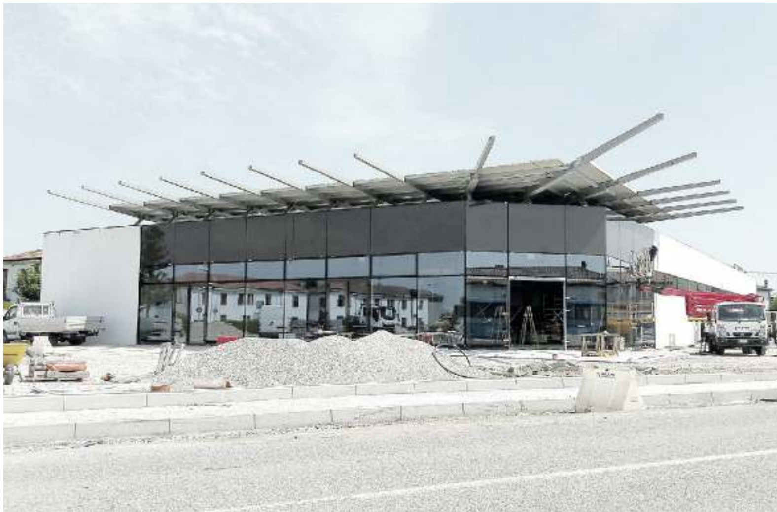
CENTRO COMMERCIALE Il cantiere per il nuovo punto vendita Aldi all'angolo con via Santa Lucia e Strada regionale 88
